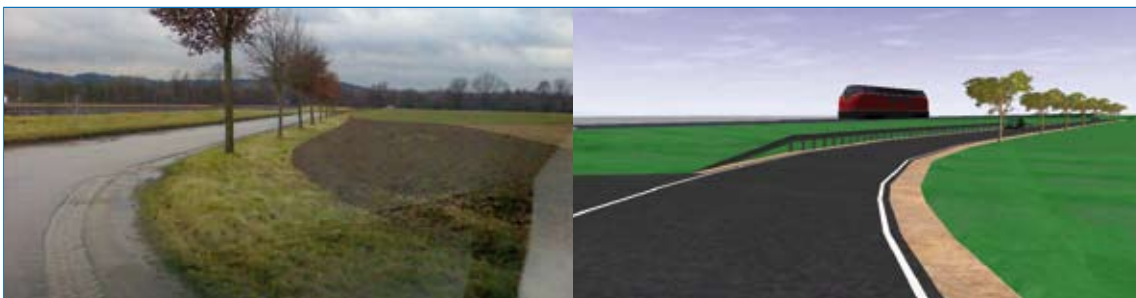
Ausbau ausserorts | Gemeinde Aschau a. Inn, GVS Klughamer Straße
